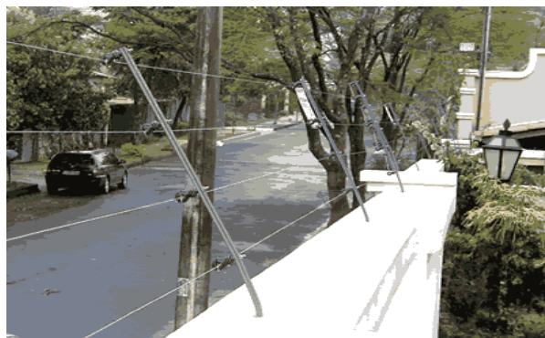
elétrica. Para testá-la ligue algum fio no terra e encoste-o, usando um pedaço de cano de PVC ou madeira bem seca, na cerca (**não segure o fio com a mão**). Ao fazer isto a sirene deverá tocar ou o alarme deverá indicar que
